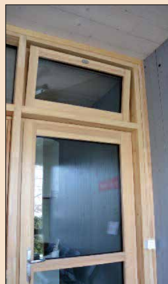
Le mur-rideau est équipé d'une fenêtre à soufflet automatique Roto pour l'ouverture du vantail.
