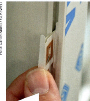
Bei Leicht wird der Chip in die Glasleistennut des Flügels geklipst.
